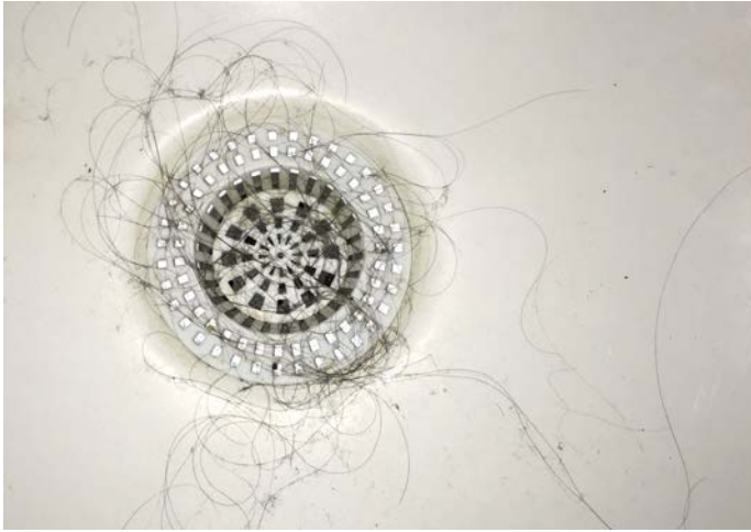
Abb. 2: das problematische Ding in Form eines verstopften Abflusses, 2017
